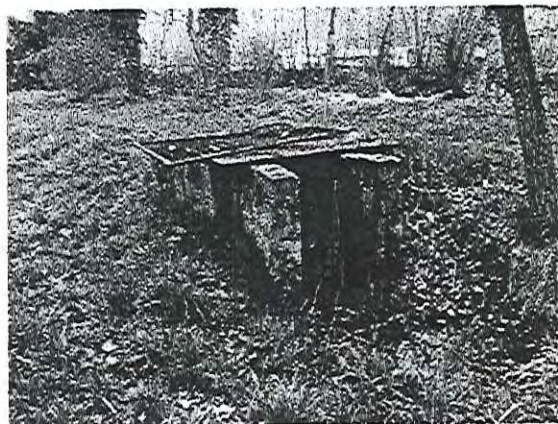
descrizione: Opera di alimentazione idrica all'allevamento ittico.
