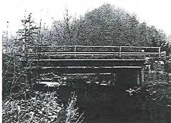
descrizione: Ponte strada provinciale n.34.
