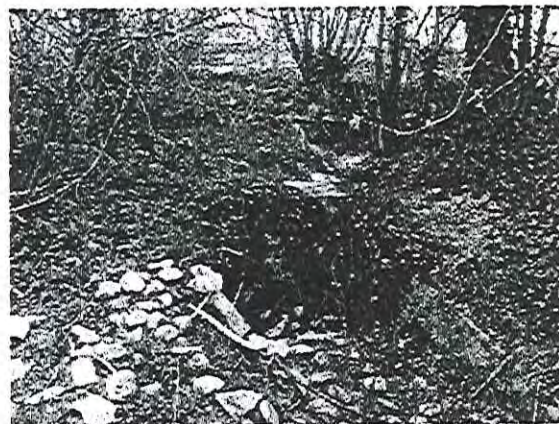
descrizione: Scolo acque agricole dismesso.
