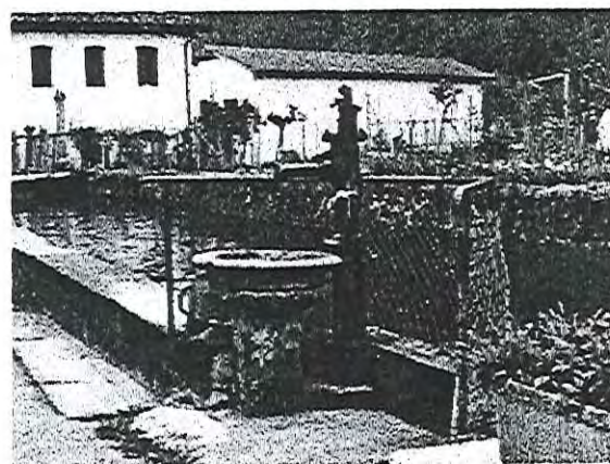
descrizione: Pompa a mano di acqua potabile ad uso collettivo.
