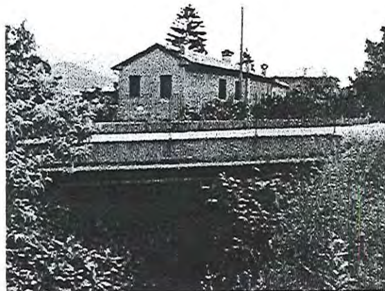
descrizione: Ponte carrabile in cemento armato.
