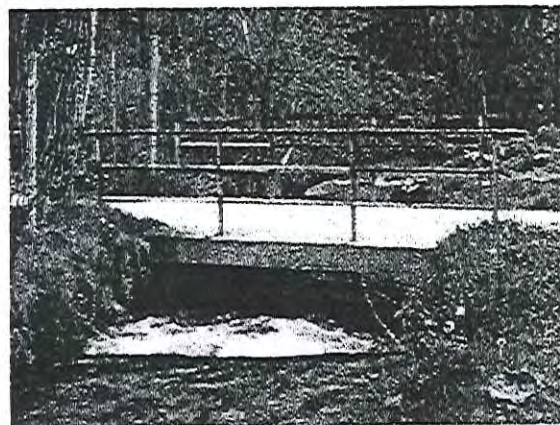
descrizione: Ponte carrabile di accesso a proprietà privata.
